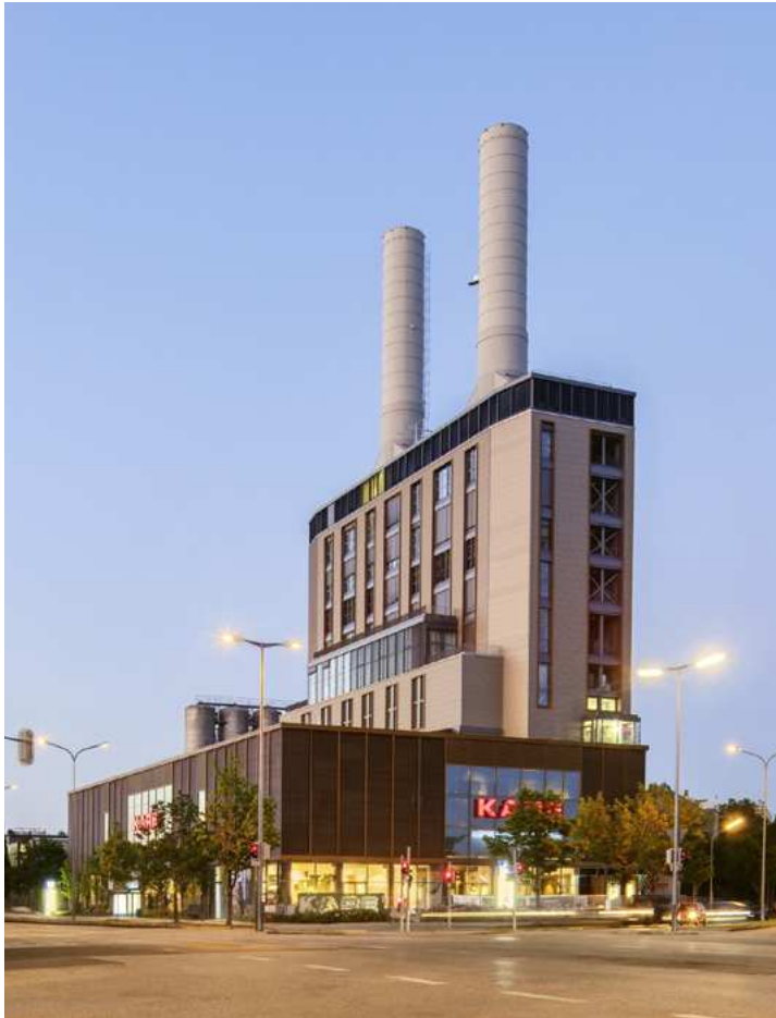
Abbildung 2 Das ehemalige Heizkraftwerk Obersending nach dem Umbau, ©Kletzsch
