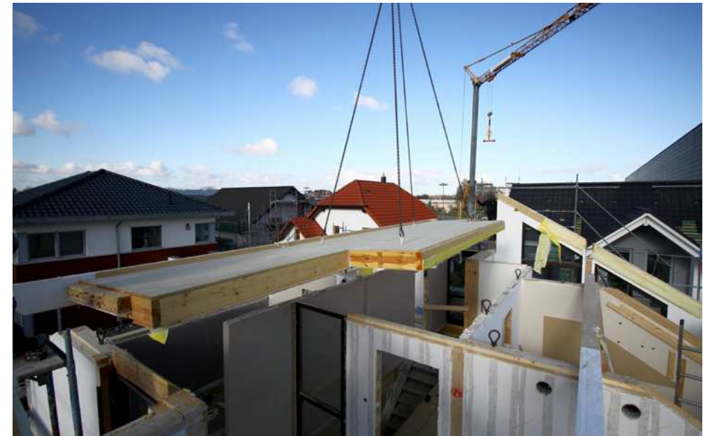
Abbildung 1, Abbildung 2 Decken- sowie Wandelemente in Holzfertigbauweise werden als ganze Teile ab- und wiederaufgebaut
