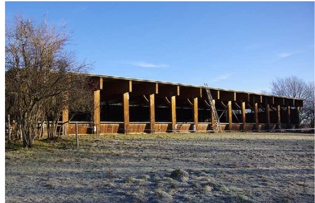
Abbildung 2 Reitstall zu 100 % aus wiederverwendeten Bauteilen errichtet
